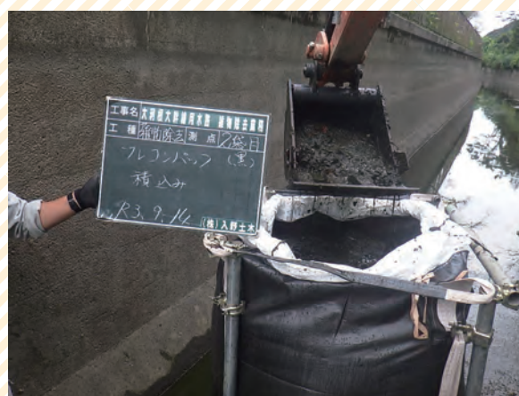
水切り土のうへの積み込み
