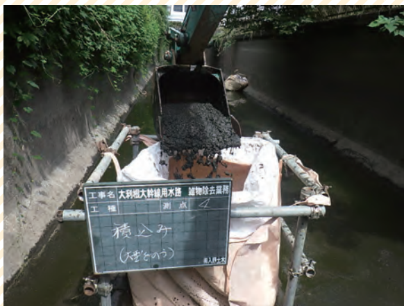
積み込み(大型土のう)
